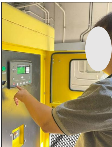
รูปภาพที่ 2.22 การตรวจสอบการทำงานของเครื่องกำเนิดไฟฟ้า
