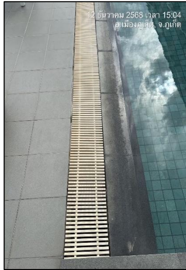
รูปภาพที่ 2.44 รางระบายน้ำฝน
